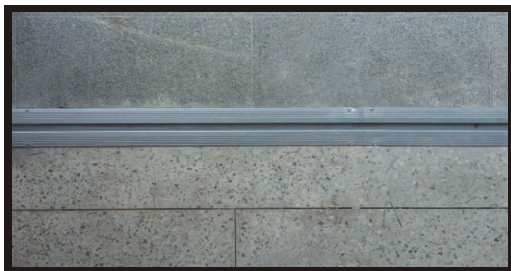
자동차 전용레일 설치된 모습입니다.
