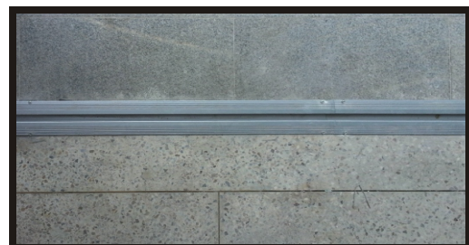
자동차 전용레일 설치된 모습입니다.
